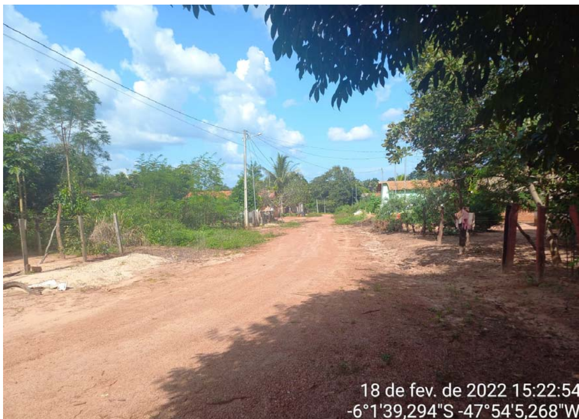
FOTO 03 – RUA B (175,49m)
